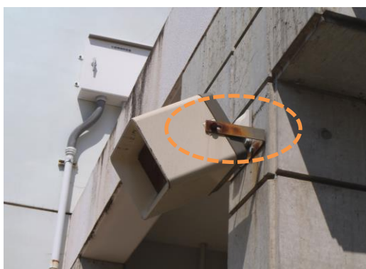
上部に固定されたスピーカーに軽度のサビが見られます。
