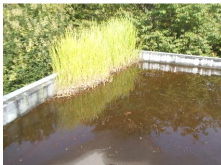
つまりを放置した結果、水がたまり雨漏りが起きやすい状態です。
