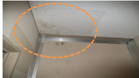
エキスパンションジョイント部に雨漏りによるシミが見られます。
