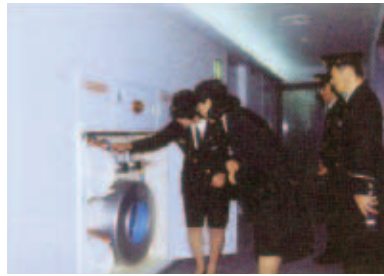
消火せつびを見て回る巡回指導
