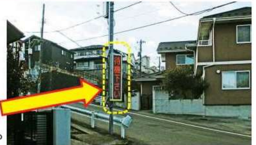
大型車感知システムの電光掲示板
