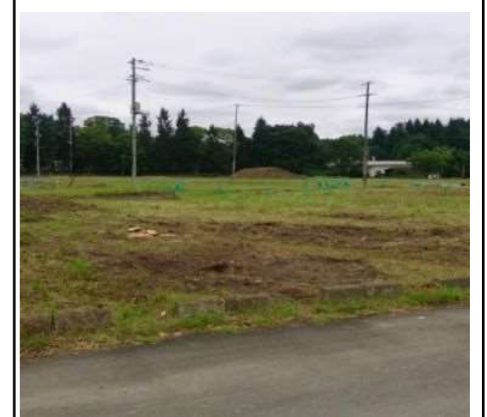
⑧追廻地区 (仮称) 公園センター地区
