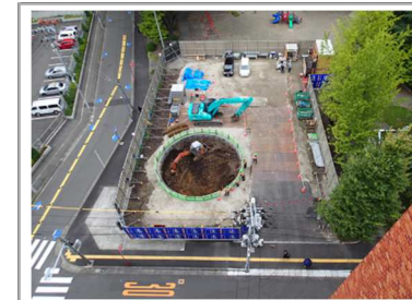
④ 発進立坑掘削工
