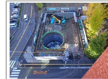
⑤ 発進立坑掘削完了
