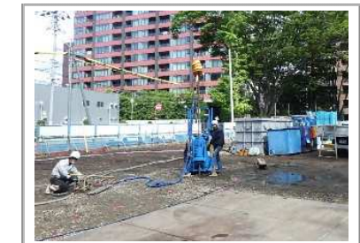
③ 薬液注入工
