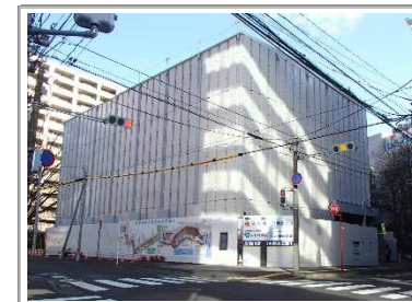
⑦ 防音ハウス完成
