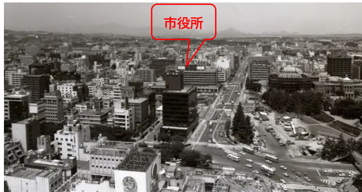
東二番丁通と勾当台通との直線化（クランク解消）工事（昭和 60 年頃）
