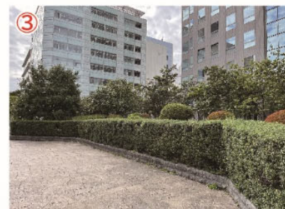
③ ステージの背景をつくり出している生垣と高木の列植は良好。ステージ脇の高木と低木植栽が、新本庁舎から南に延びる軸線に干渉する。
