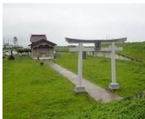
震災後再建された五柱神社
