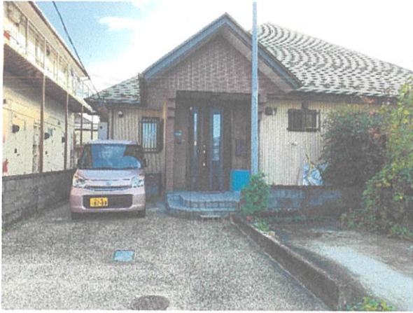
保育ルーム外観です。車での送迎OKです。
