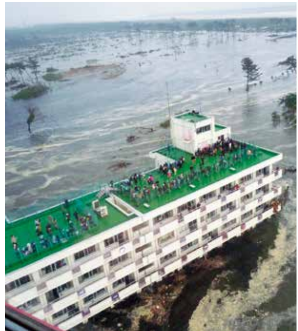
津波により孤立した荒浜小学校では生徒や教師、地域住民が屋上で助けを待った（若林区）
