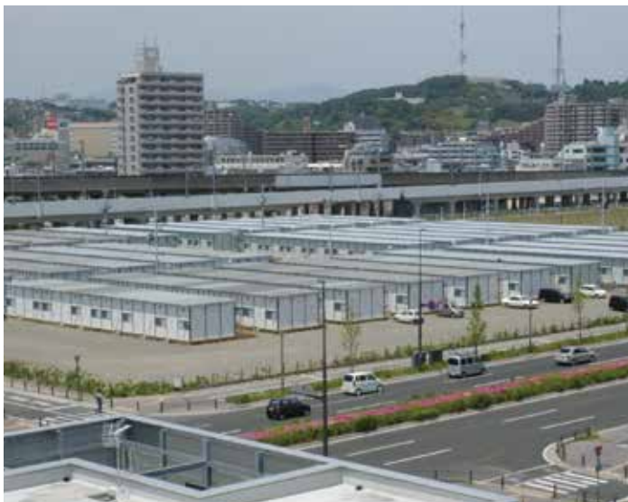
太白区あすと長町の仮設住宅
