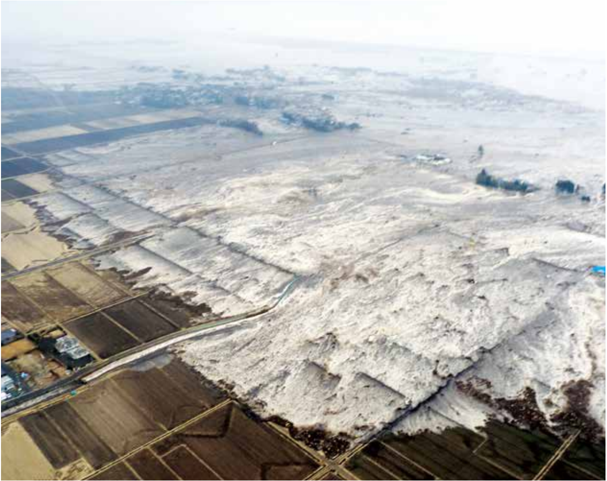
若林区藤田集落。巨大な波が防潮堤をなぎたおしている
