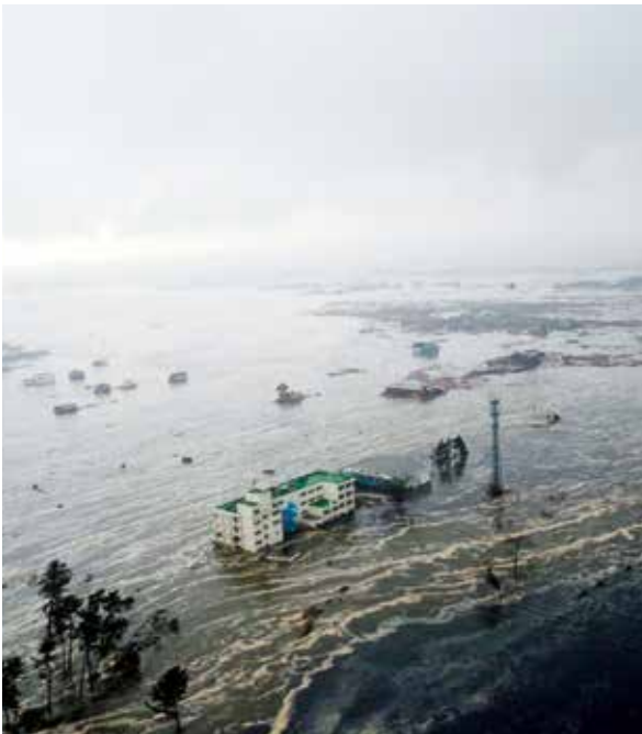
荒浜小学校から南西方向を見る（若林区）
