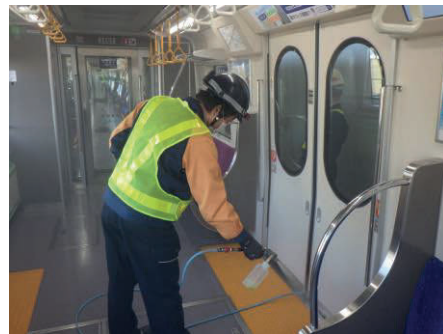
地下鉄内の抗ウイルス加工処理作業
