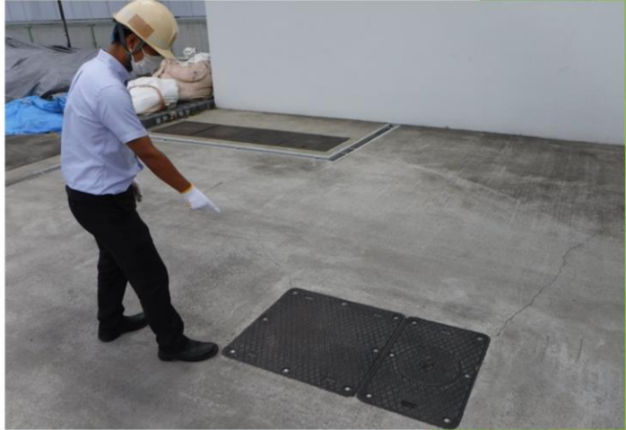
マンホール破損有無の確認
