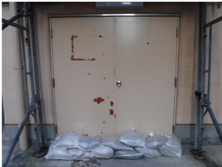
土のうによる建屋への浸水対策
