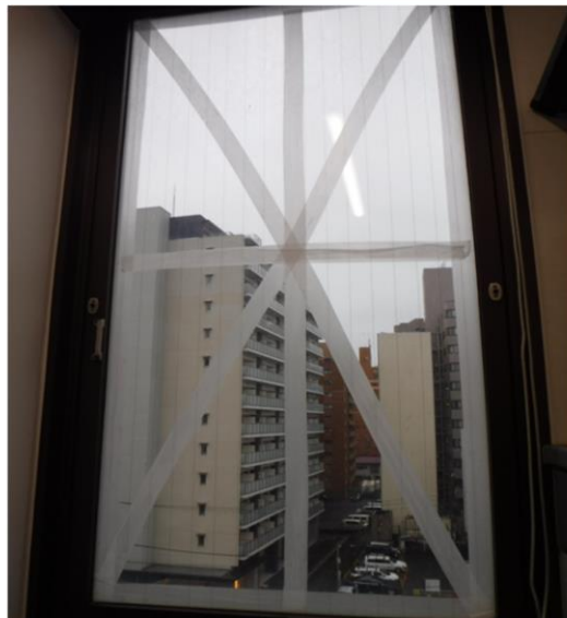
施設内ガラス窓への飛散防止措置
