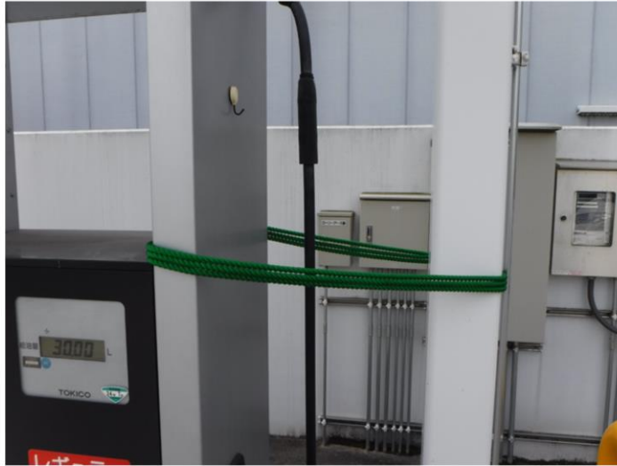
ロープを使用し、固定給油設備とキャノピーの柱を緊結
