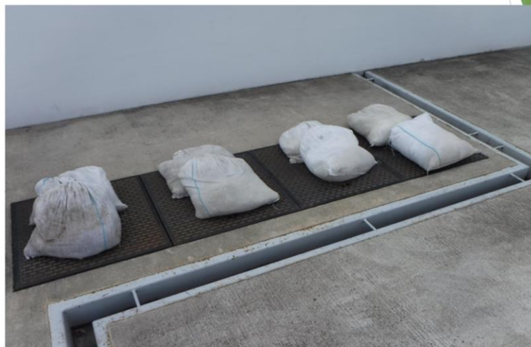
流出防止のため油分離層のふたに土のうを設置した様子
