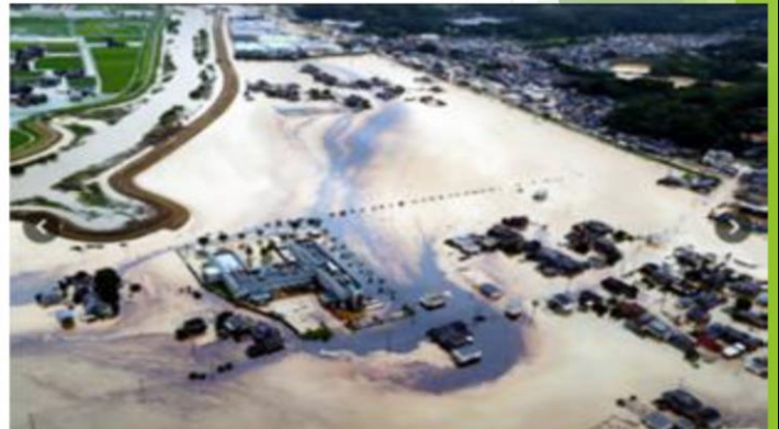
危険物（焼き入れ油）の流出状況
