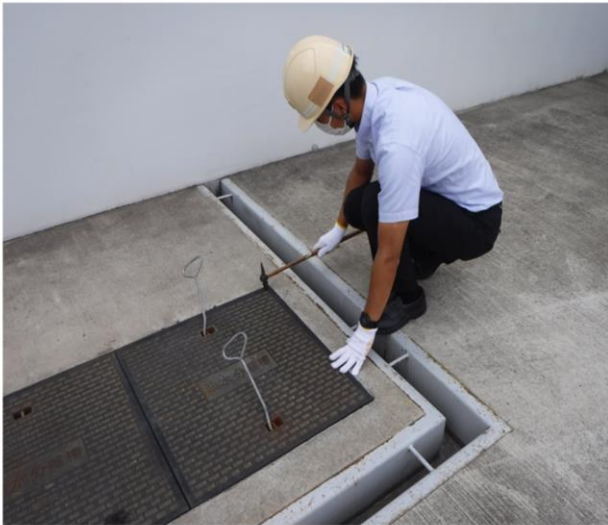
油分離層のふたのずれを直している様子
