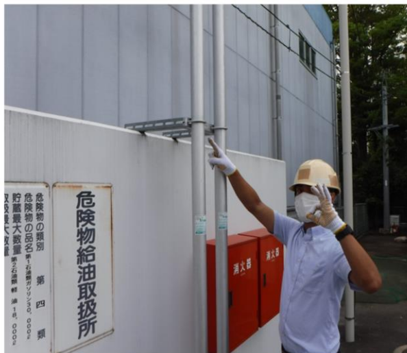
通気管の固定状況を確認する様子
