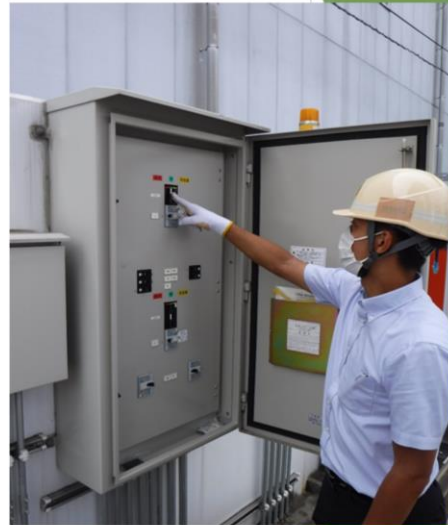
電源を再始動する様子
