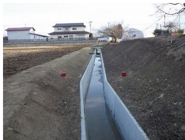
野村水路改修
