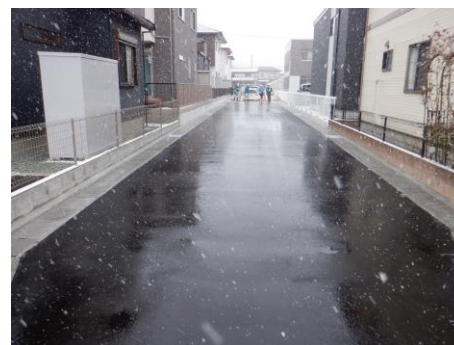
四郎丸農道舗装整備
