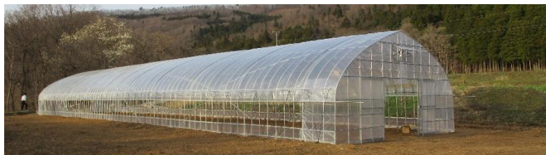
補助金で整備したパイプハウス
