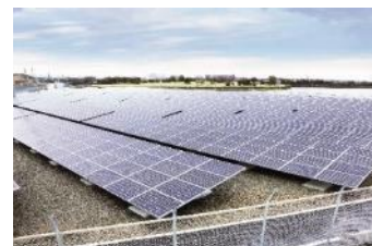
大沼太陽光発電所
