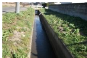
水路土砂浚渫後
