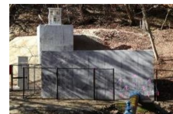
朴沢小水力発電所
