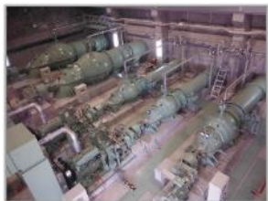
排水機場ポンプ
