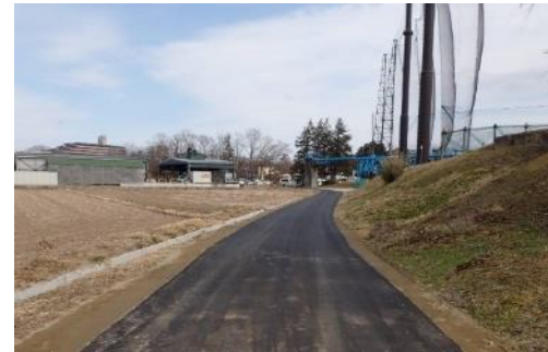
野村農道舗装整備
