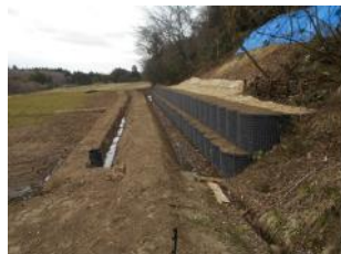
農業用水路修繕
