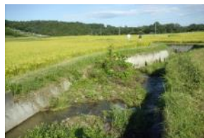
水路土砂堆積状況
