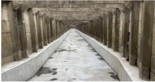
高砂水路長寿命化対策工事
