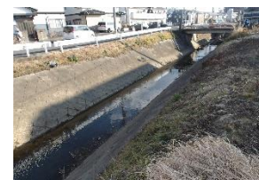
水路土砂浚渫後
