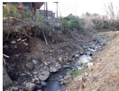
水路法面の浸食 玉石による水流阻害
