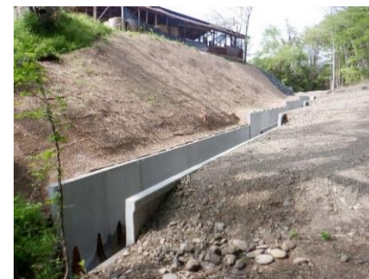
コンクリート水路に改修
