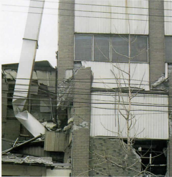
地震により中間層が破壊しています。
