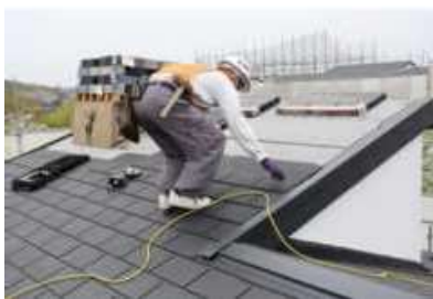
屋根の断熱化工事
