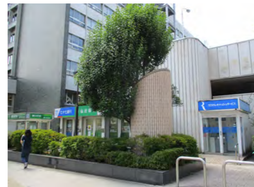
現況写真①
