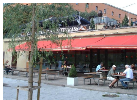
1階飲食店と屋外のベンチ・テーブルの 一体利用の例
