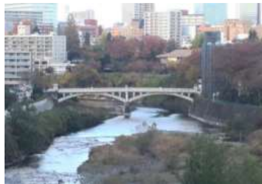
広瀬川にかかる橋りょう(霊屋橋)
