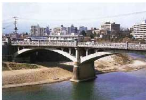
橋りょうのデザイン(霊屋橋)
