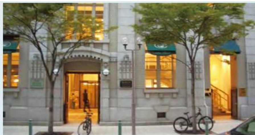
ピロティの明かりを街路にこぼしています。
