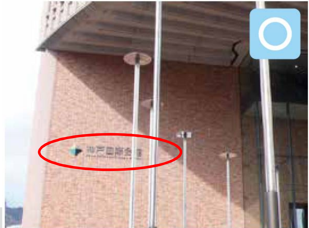
適度な大きさ の広告物により、建物の「顔」をつくることもできます。
