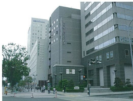
2階以上の階も壁面を後退し、開放感を高めた建築物の例
