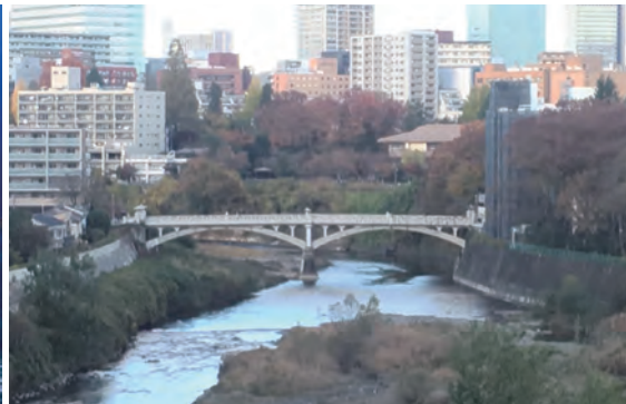
広瀬川にかかる橋りょう(曇屋橋)
