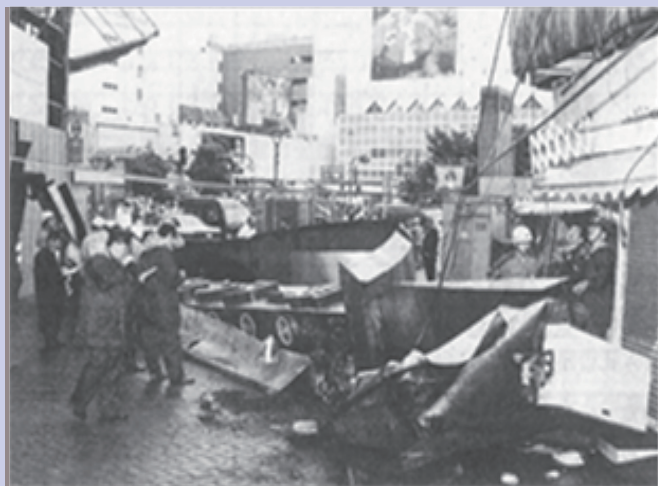
台風で落下した時の様子
