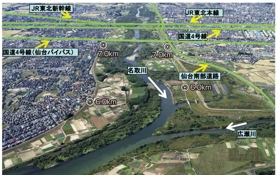
東北地方の主要交通網が集中する広瀬川合流点付近(仙台市太白区)
