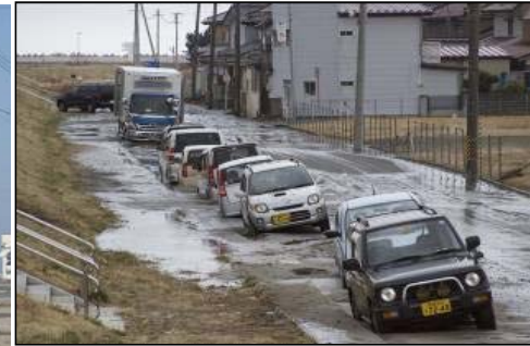
地震による堤内地の液状化
