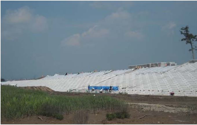
被覆工(コンクリートブロック)の設置状況
