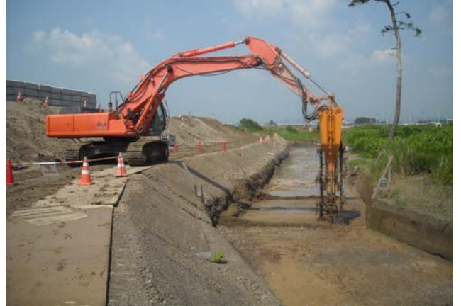
川裏側法尻部の地盤改良状況
