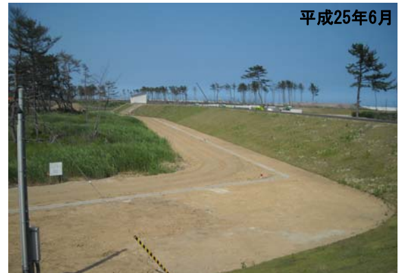
川裏側法尻部の地盤改良状況
