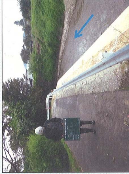
ブロック積護岸による復旧 及び農道の復旧
