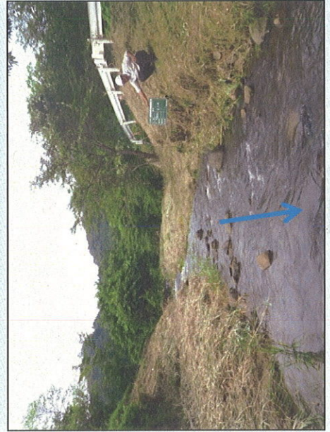
ブロック積護岸による復旧 及び堆積土砂撤去による 流下断面の確保
