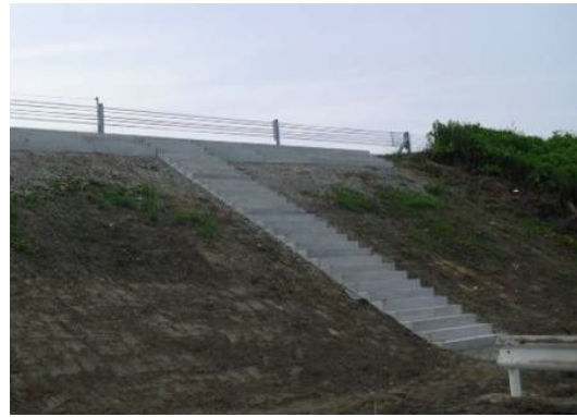
津波避難施設（避難階段）の例
