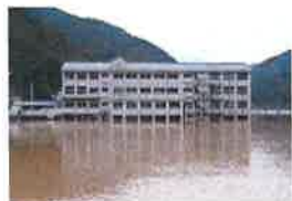
H26. 8 避難所2階の浸水(徳島県)
