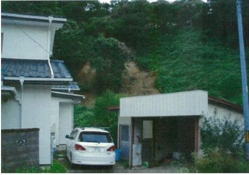
太白区三神峯：人家裏の斜面崩壊
