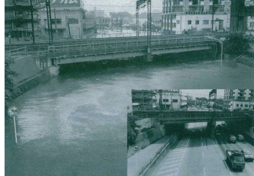
青葉区五橋～若林区新寺 都市計画道路 清水小路多賀城線：深さ 4m 以上浸水し、 道路寸断
