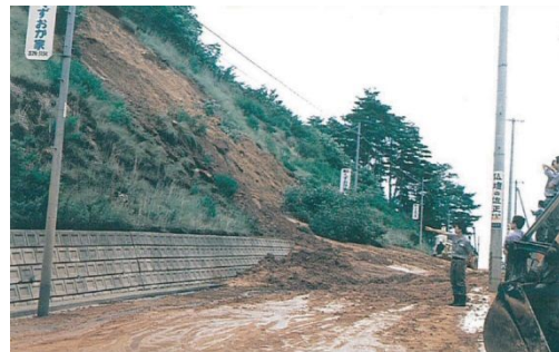
青葉区葛岡墓園付近：崖崩れにより道路寸断
