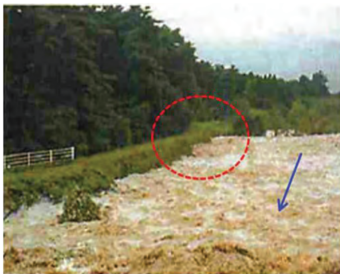
図 - 10 水際線の異常の例
