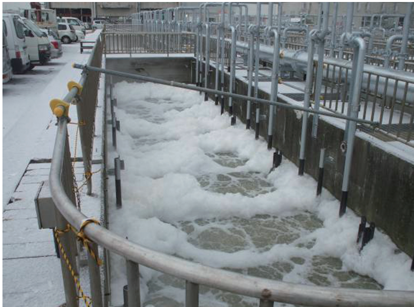
微生物を利用した暫定的な二次処理（接触酸化法）を本格稼働（平成24年3月）
