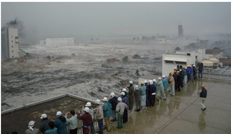
津波により水没する水処理施設（最初沈殿池）
