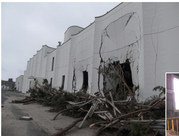
送風機室建屋壁面
