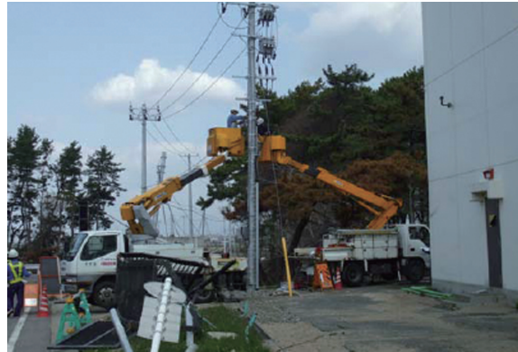
高圧鉄塔が津波により被災し、特高受電ができないため、仮設の電柱により高圧受電を行う（平成23年5月）
