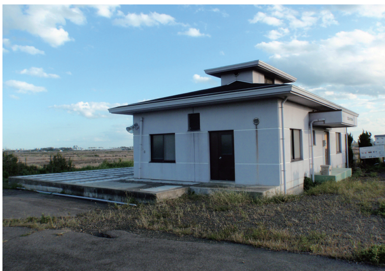
現在、仮復旧し運転中（平成23年7月～） （本復旧は平成25年度以降の見込み）
