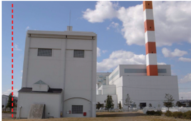
今泉雨水ポンプ場の第2ポンプ棟が地震により傾斜（平成25年2月本復旧完了） ※右側の建物は今泉清掃工場
