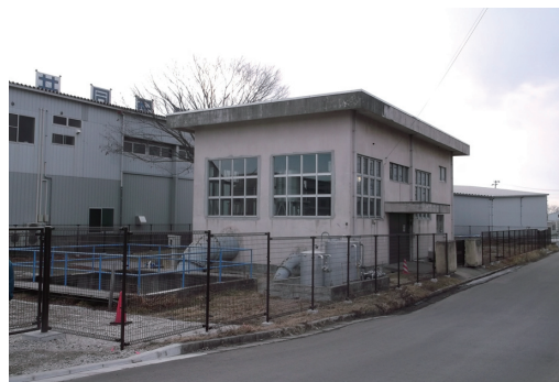
復旧工事完了（平成24年10月）
