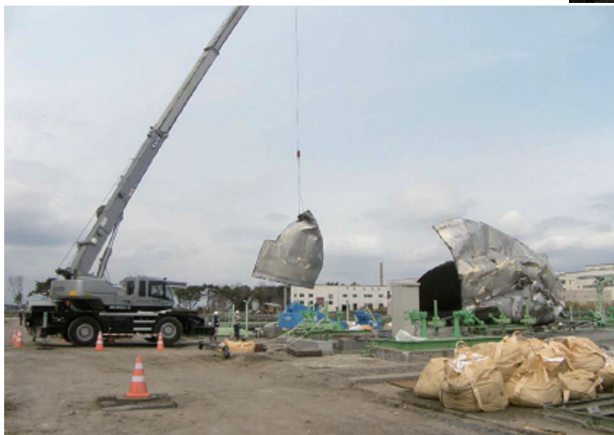
流出したガスタンク上蓋の撤去
