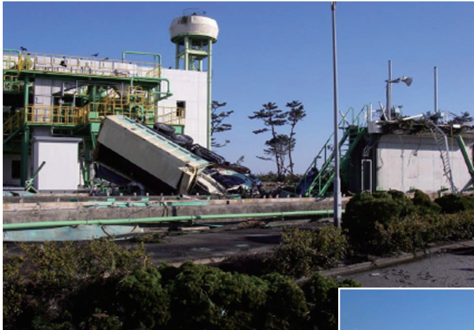
津波により流された廃棄物運搬車 (導水渠付近)
