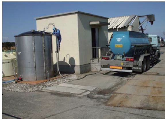
固形塩素消毒から次亜塩素酸ソーダによる消毒に切り替え (平成23年4月)
