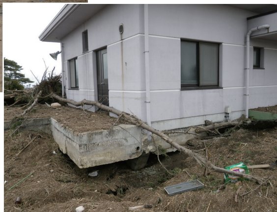
クリーンセンター基礎部分
