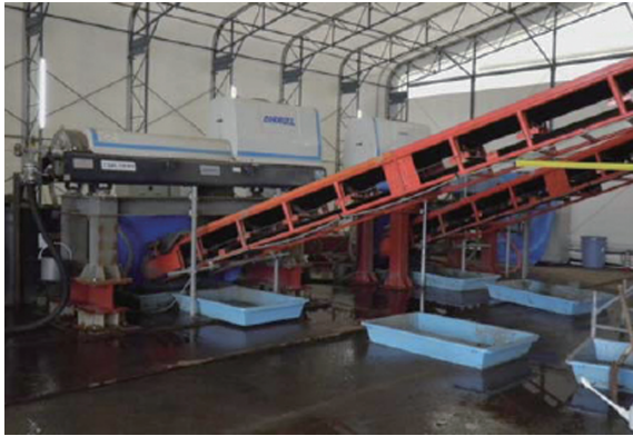
仮設の遠心脱水機が運転開始（平成23年4月）
