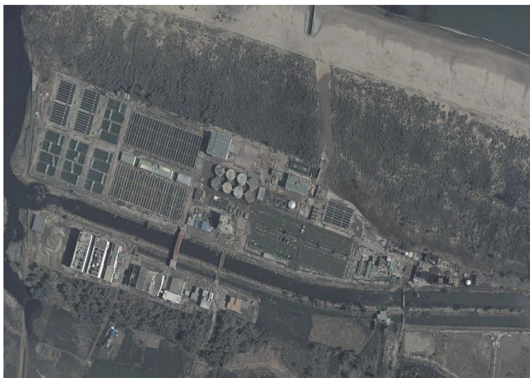
南蒲生浄化センター全景（被災後）
