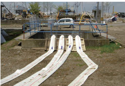
仮設排水ポンプを設置（平成23年5月）
