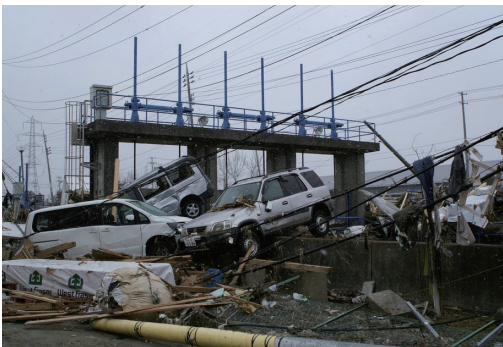
西原排水ポンプ場切替ゲート付近
