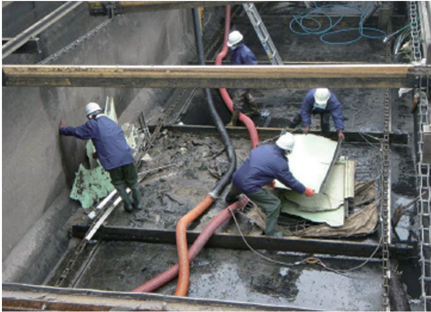
最初沈殿池等槽内のがれきを撤去
