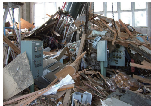
津波によるがれきに埋もれる西原排水ポンプ場
