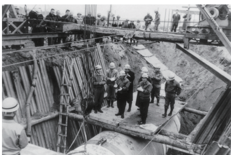
敷設状況（φ2,100mm ヒューム管 印籠継手）
