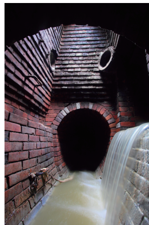
卵形渠：袋町幹線 明治36年度竣工 敷設場所：東北大金研付近
