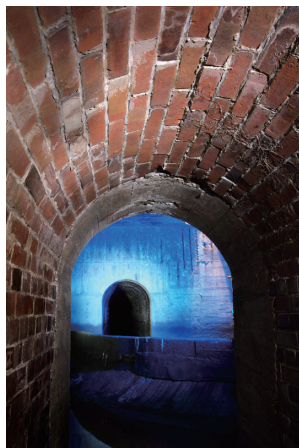
馬蹄形渠：定禅寺通幹線 明治33年12月竣工 敷設場所：定禅寺通下
