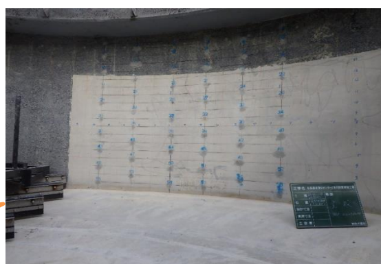
耐震補強の例（秋保温泉浄化センター）
