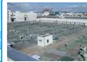
「南蒲生浄化センターのばっき槽(反応タンク)」下水道管を流れてきた汚水をきれいにしています。
