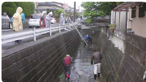
河道内の清掃
