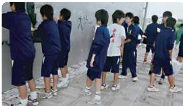
橋梁の落書き消し
