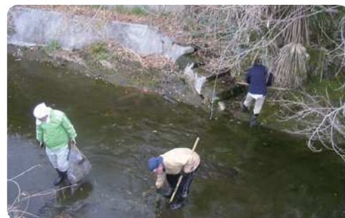
東仙台松原地区での伐採作業
