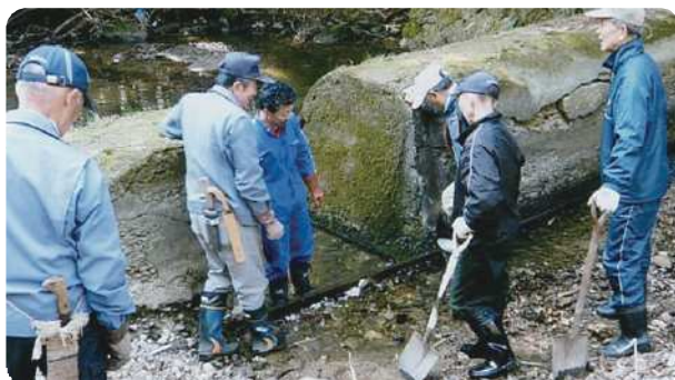
齋勝川の堰改善作業
