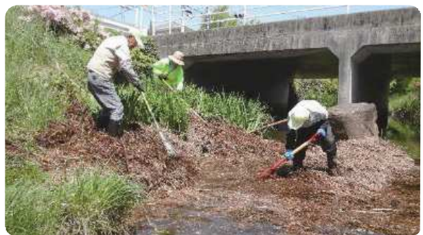
桜橋下の堆積物の除去
