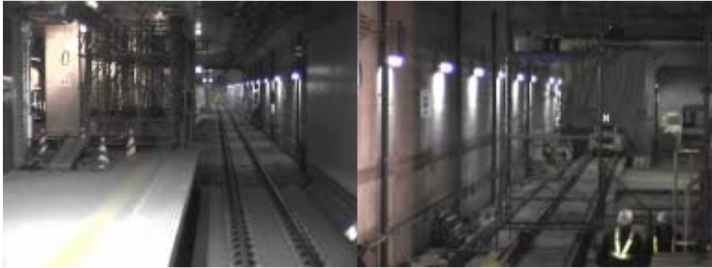
(図表 24) 泉中央駅留置線延長工事の様子
