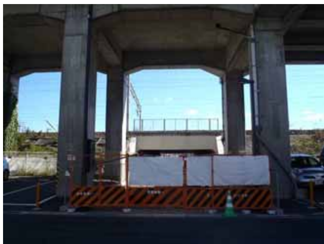
③地下鉄長町一丁目アプローチ
