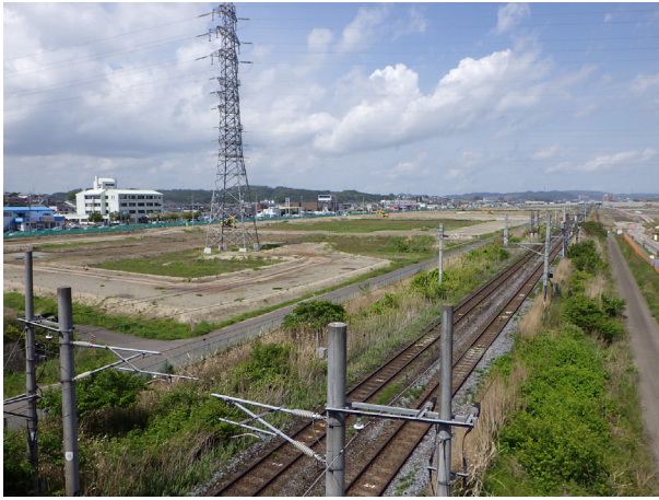
No.11 国道4号跨線橋（北方向）
