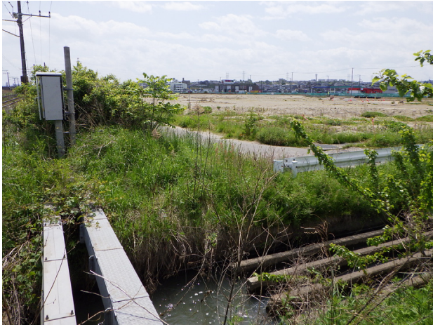
No.1 大井川踏切（西方向）
