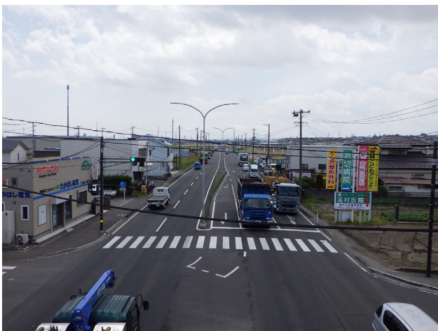
No.4 岩切歩道橋（南西方向）
