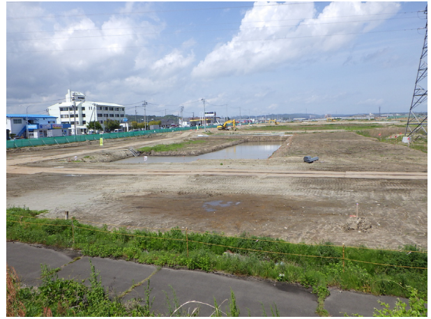
No.12 国道4号跨線橋（北西方向）
