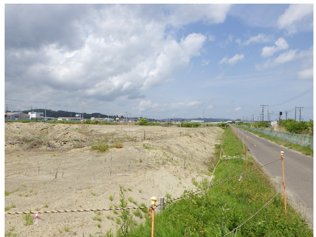
No.15 事業区域内（北東方向）
