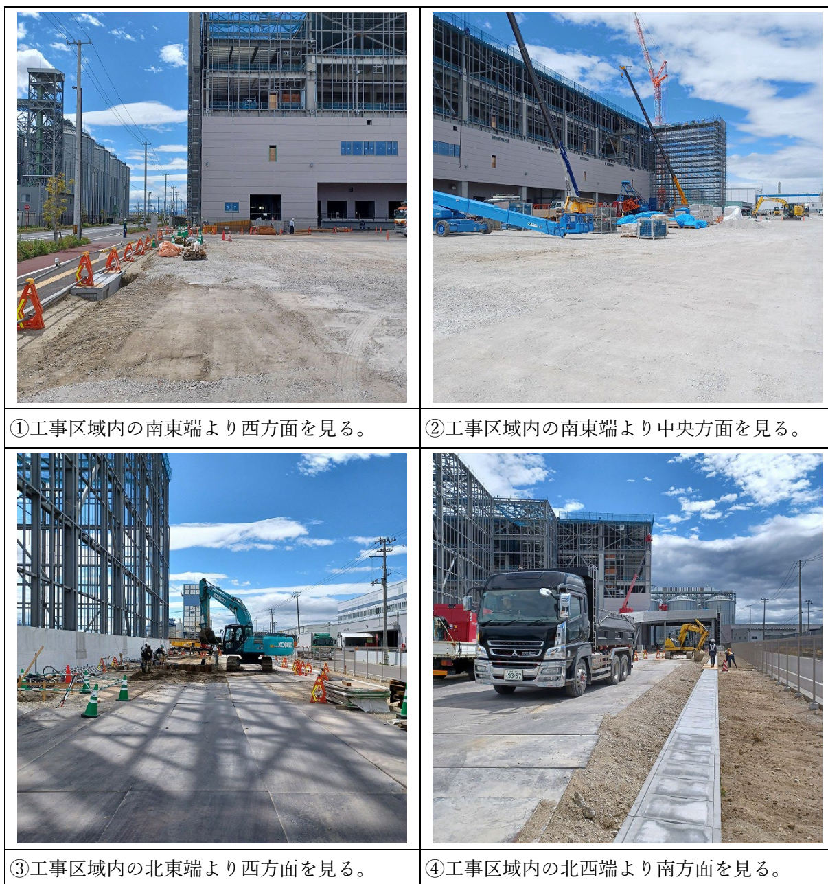
写真 6.1-1 調査期間中の工事区域内の状況
