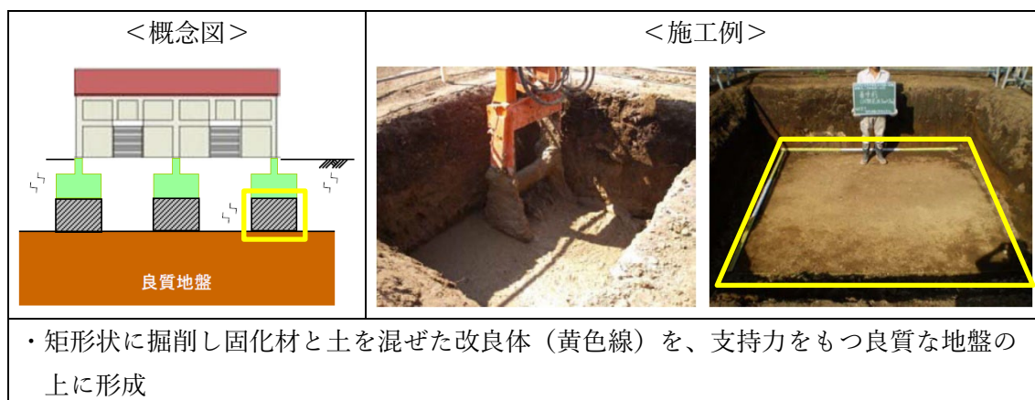
図 1.8-1 地盤改良工事のイメージ
