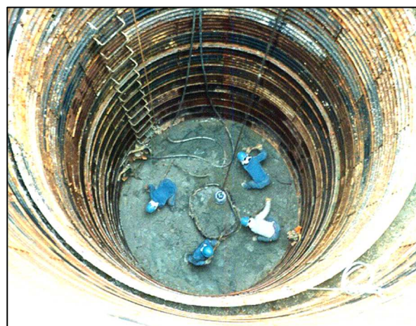
鉄塔工事－基礎工事
