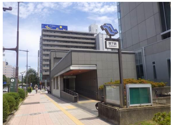
⑧ 仙台市営地下鉄南北線五橋駅
