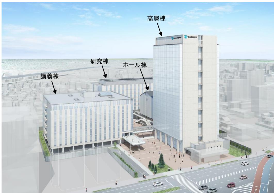
図 1.6-2(2) 完成図（工事完了時）
