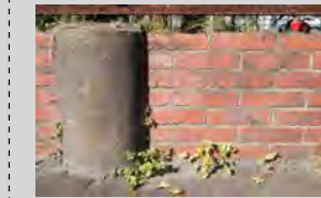
▲敷地外周に残る煉瓦壁
