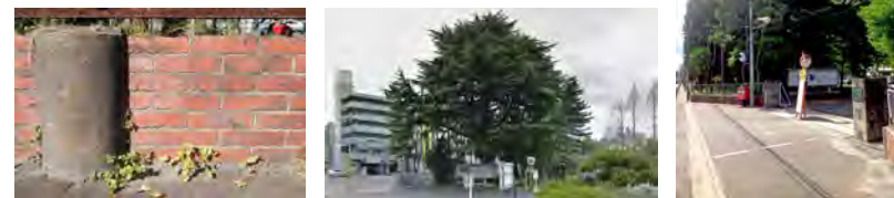
▲敷地外周に残る旧第二高等学校建設当時の煉瓦壁
