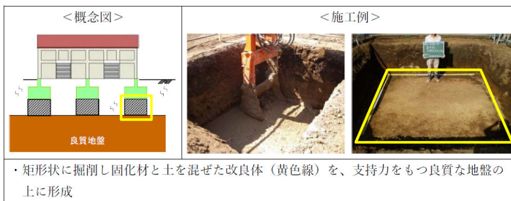
図 1.8-1 地盤改良工事のイメージ
