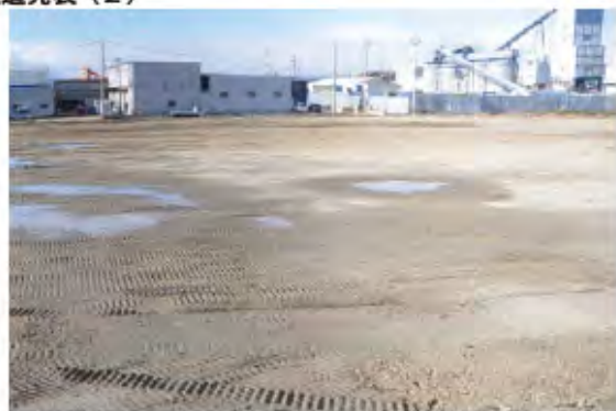
埋戻し後の状況 (東から)
