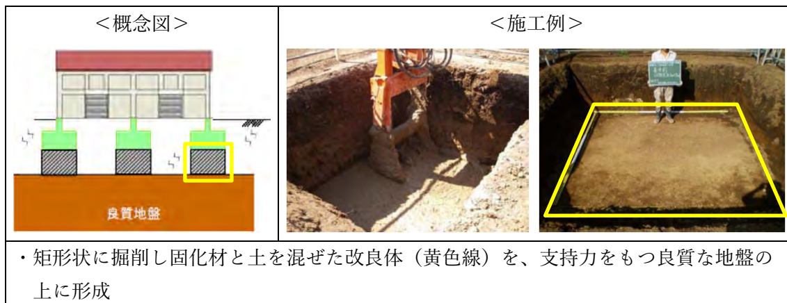
図 1.8-1 地盤改良工事のイメージ
