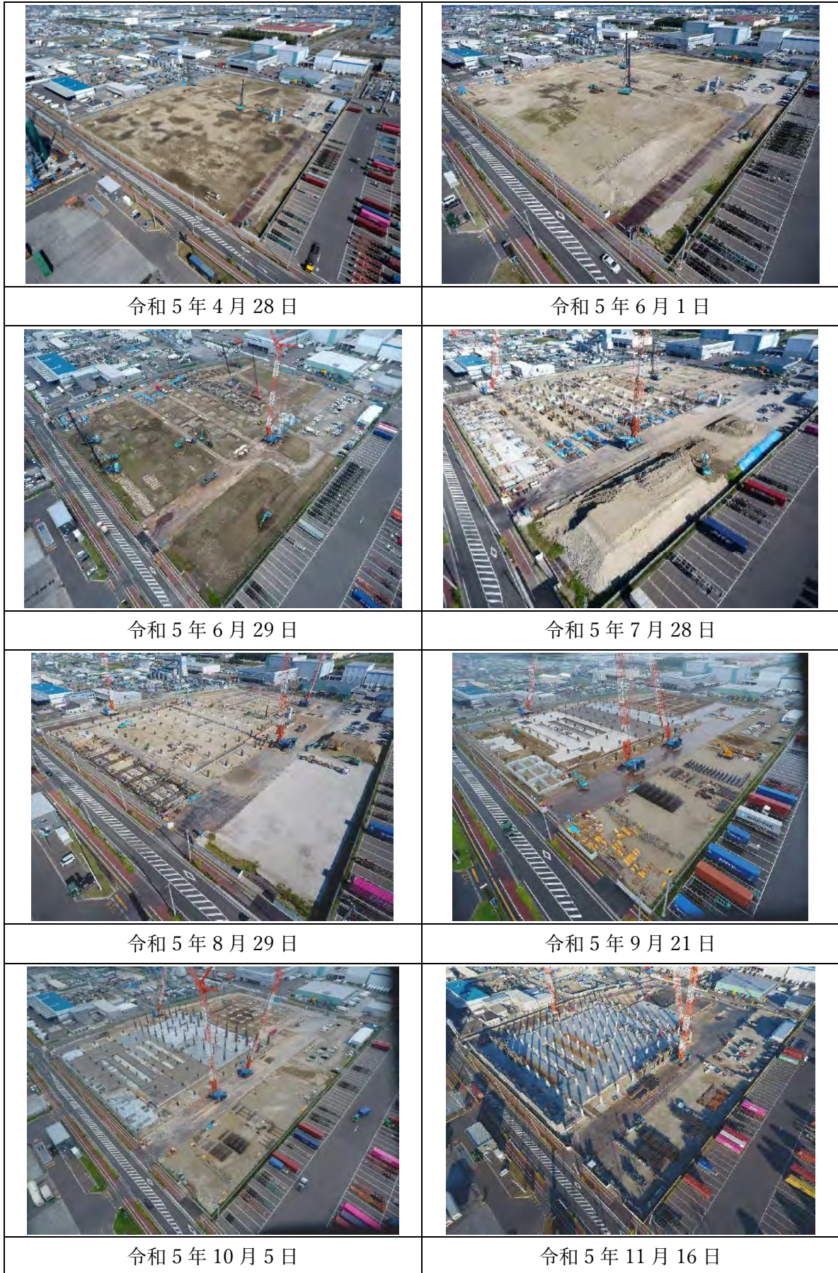
写真 3-1(1) 工事の進捗状況 (1/2)
