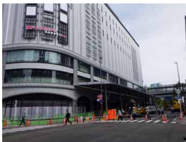
No.6 東七番丁通り辻標52番対角付近から北西方面 (撮影日：令和5年5月16日)
