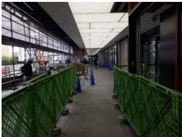
令和5年5月16日 連絡通路工事
