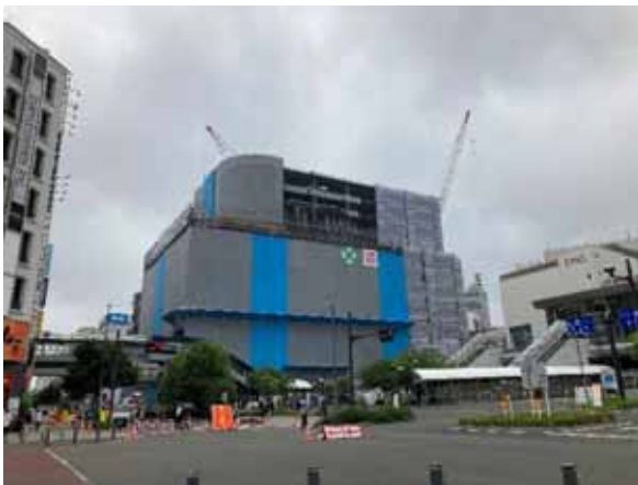
令和4年7月11日 地上階躯体建設
