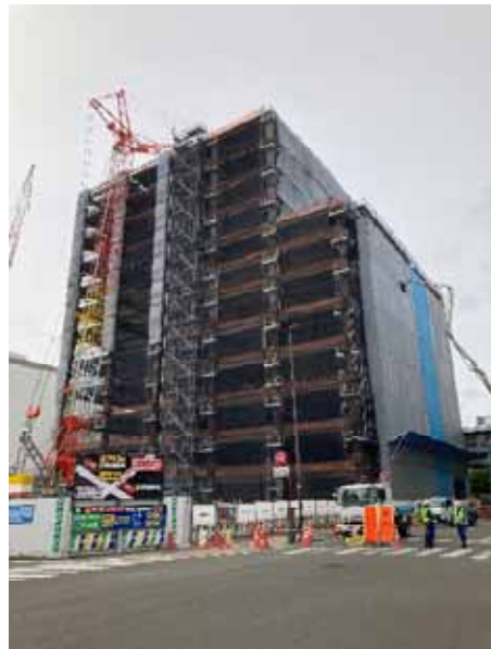
令和4年6月14日 地上階躯体建設
