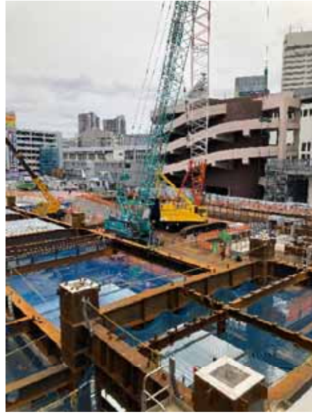
令和4年6月14日 地上階躯体建設
