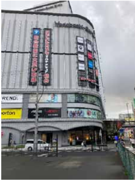
令和5年7月20日 建物南東側
