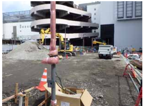
令和5年5月16日 建物南西側平面駐車場工事
