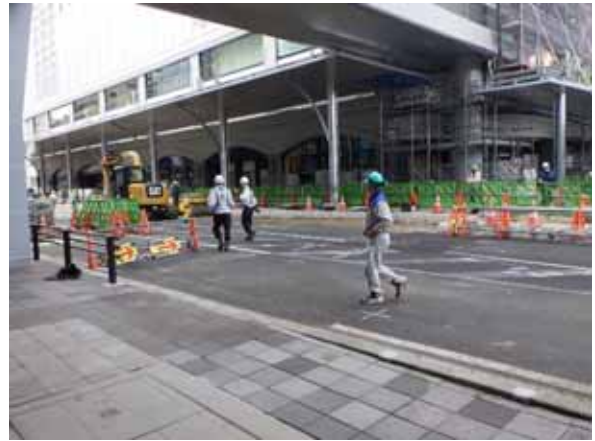
令和5年5月16日 地上部バスベイ建設
