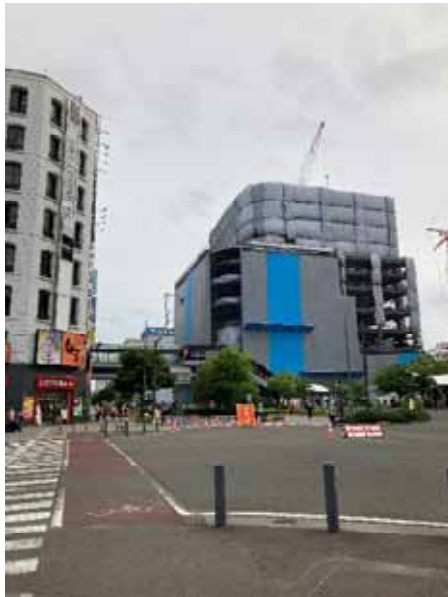
令和4年6月14日 地上階躯体建設
