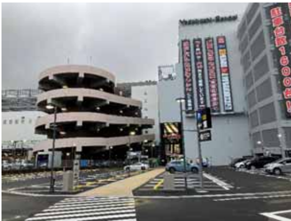
令和5年7月20日 建物南西側平面駐車場
