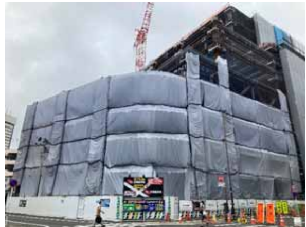
令和4年7月11日 地上階躯体建設
