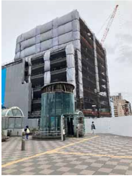
令和4年6月14日 地上階躯体建設
