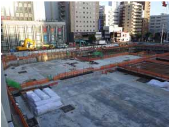
令和4年4月8日 地下階建設
