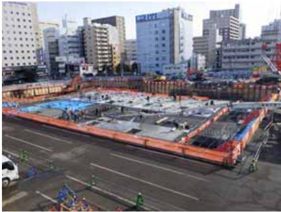
令和4年1月18日 地下階建設
