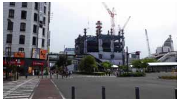
令和4年5月10日 地上階躯体建設
