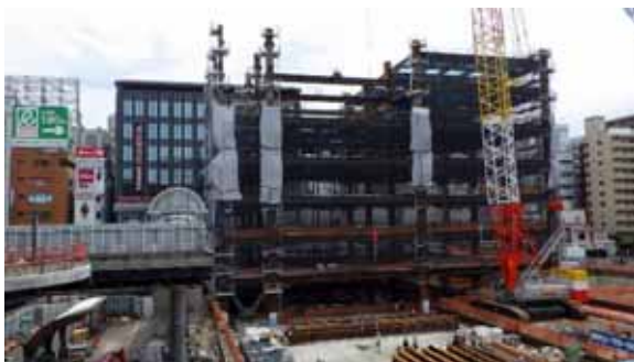
令和4年5月9日 地上階躯体建設
