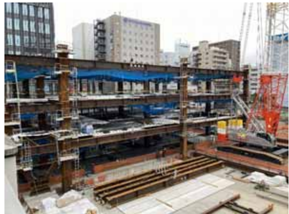
令和4年4月26日 地上階躯体建設
