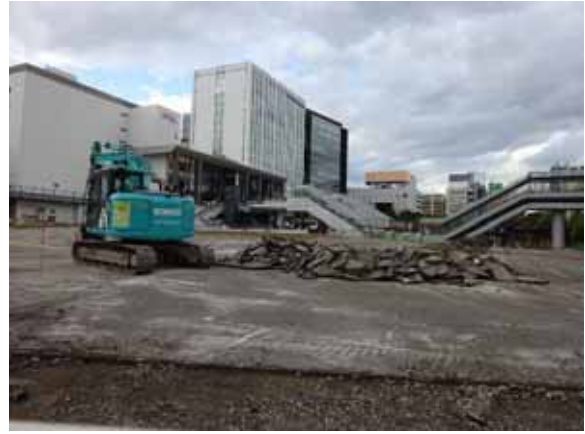
令和3年10月22日 駐車場解体
