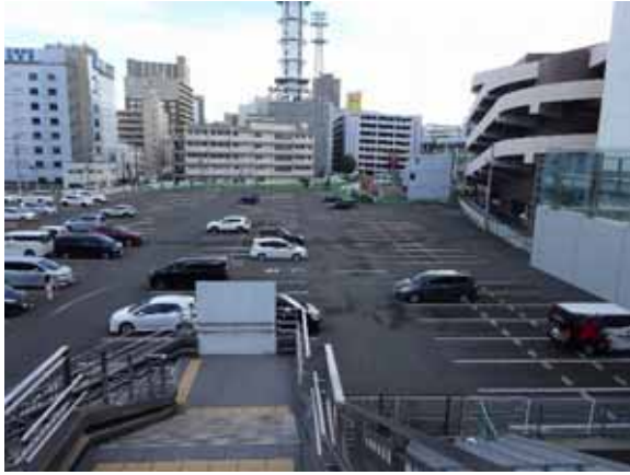
令和3年8月18日 工事事務所建設
