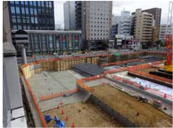
令和4年3月3日 地下階建設
