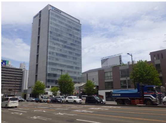
③ 一般国道 286 号より対象事業計画地南西側を望む
