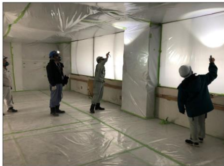
撤去前養生検査
